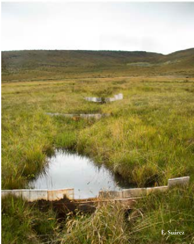
Figura 4. Ejemplos de las barreras construidas con tablas de madera en los canales más anchos y profundos.
