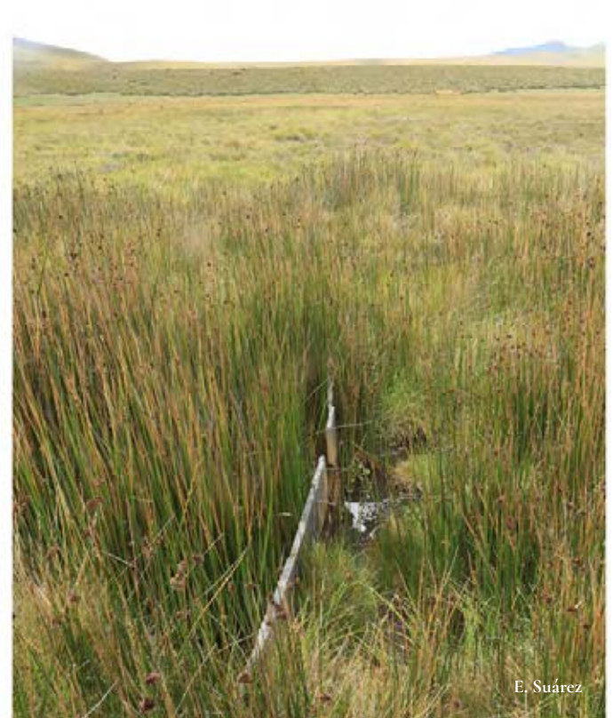
Figura 4. Ejemplos de las barreras construidas con tablas de madera en los canales más anchos y profundos.
